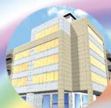
Κτίριο Γραφείων Κ.ΚΟΤΤΗ Αθήνα
