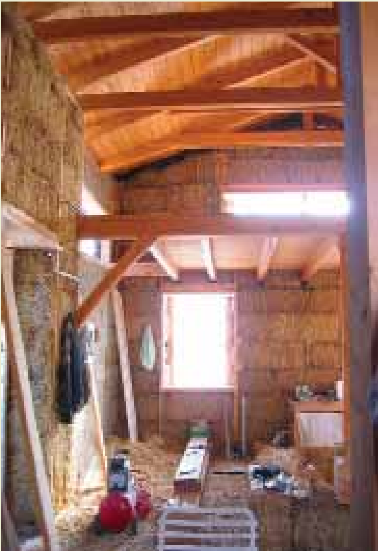
Οικολογική δόμηση στην Αίγινα: κατοικία από άχυρο, ξύλο και λάσπη. Μικρό κόστος υλικών και πολλή προσωπική εργασία από τον ιδιοκτήτη.
